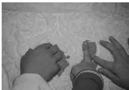
**Figura 1** · Aplicação do silicone com a adição do espessante (tixotrópico) através de espátula. Fonte: própria
