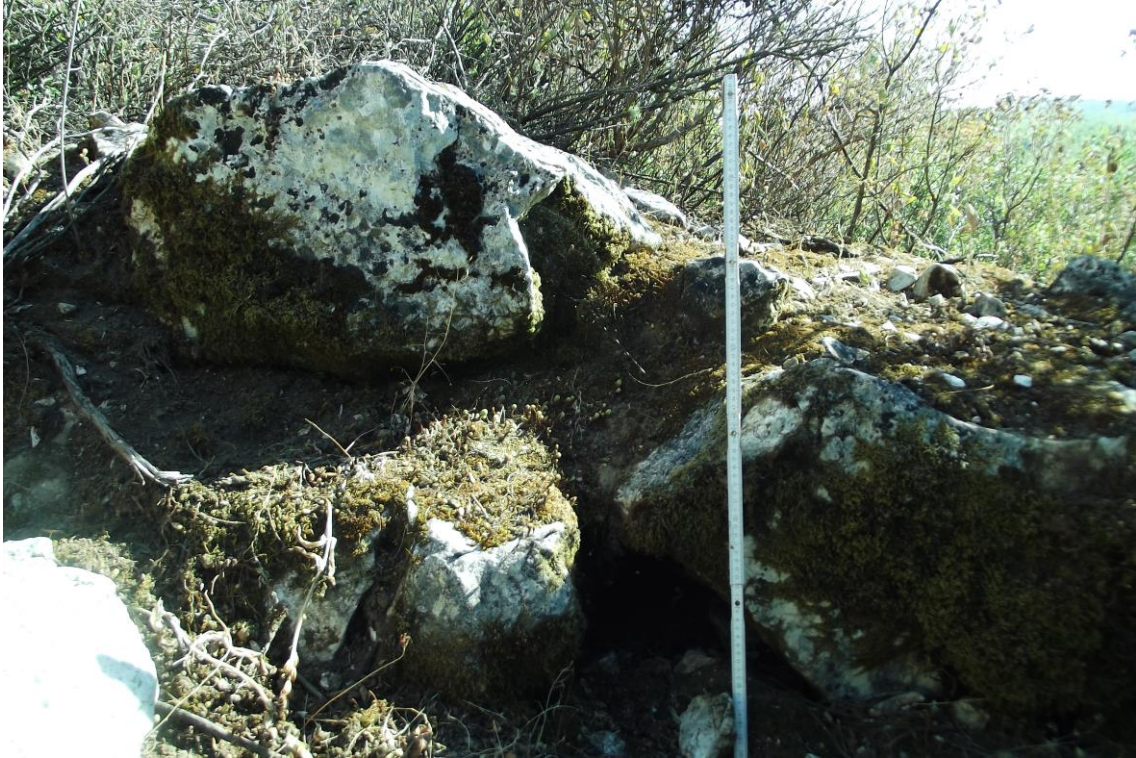
Fotografia 11 - Estrutura 3, detalhes construtivos
