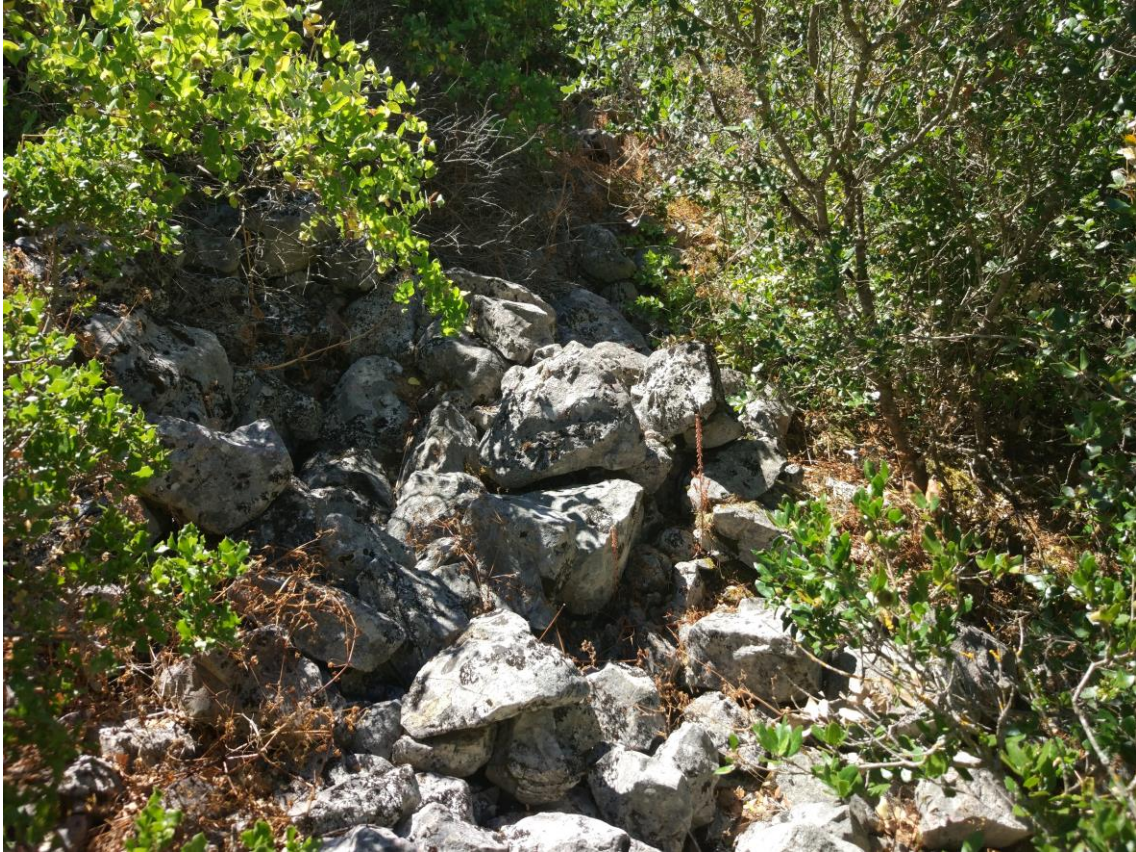
Fotografia 7 - Estrutura 1, paramento exterior da muralha
