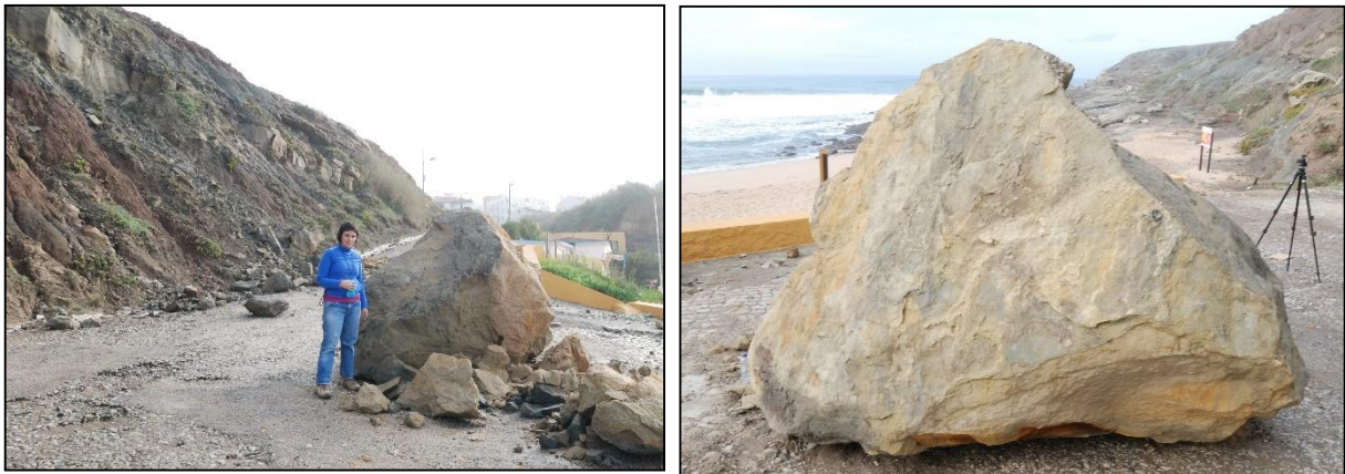
Figura 114 – Bloco depositado na estrada de acesso ao areal, proveniente do talude – queda de blocos a 30/11/2012.
