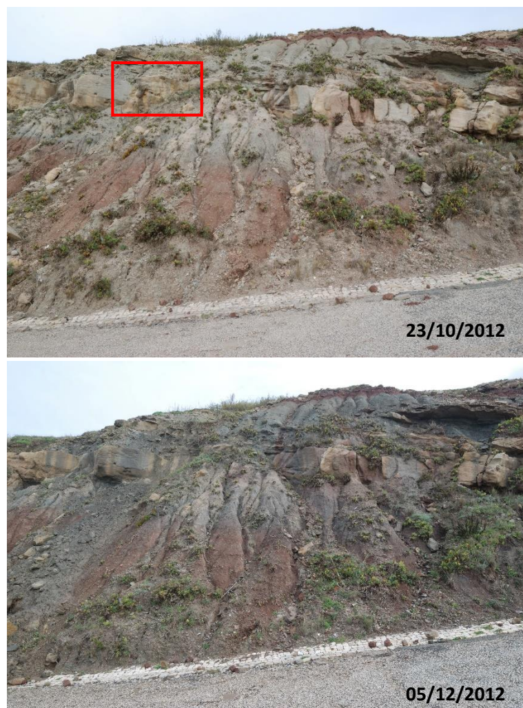
Figura 112 – Em cima, imagem original do levantamento fotogramétrico para estabelecimento da Época 0; em baixo: levantamento fotogramétrico após queda de blocos a 30/11/2012 – Época 1.
