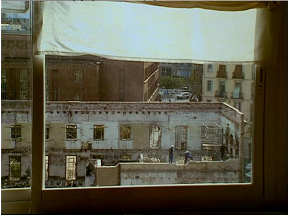
[Fig. 72] Obres de reforma a l'edifici filmat a En construcció
