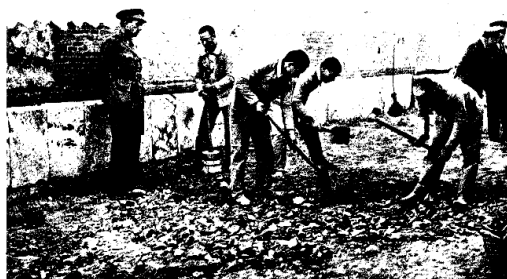
Reclusos efectuando trabajos de pavimentación en uno de los patios
