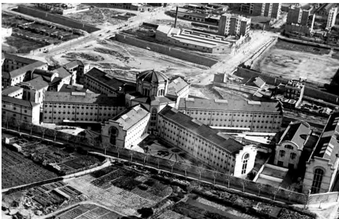
[Fig. 21] Construcció de la presó Model
