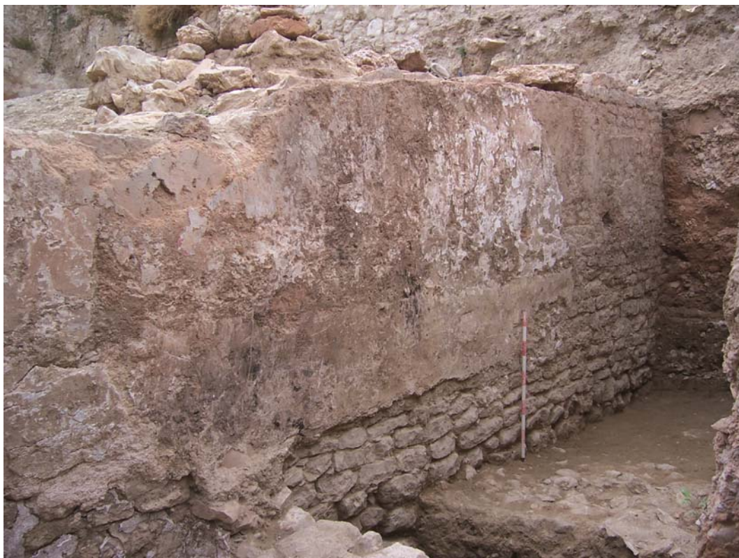
Fig. 55. La principal estructura documentada a Sant Felip Neri. Parament d' opus vittatum cobert amb estuc (GRESEPIA)
