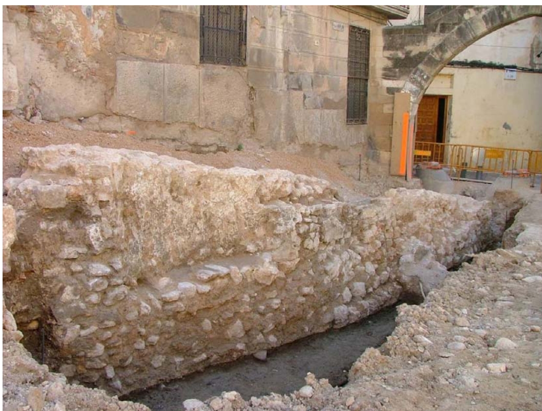
Fig. 49. La possible muralla andalusina localitzada a la plaça de l'Absis (Griñó i Camarasa 2011)
