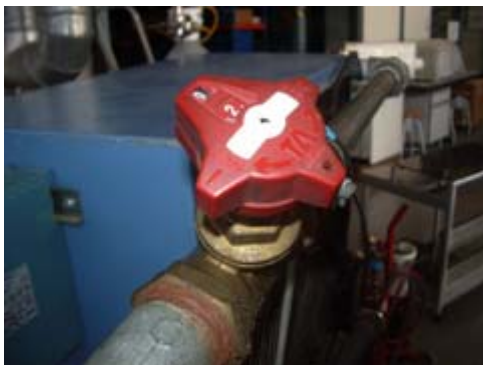
Fig. 4.15 Válvula de equilibrado STAD.
