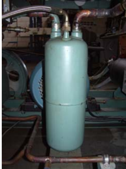
Fig. 4.20 Botella de separación de aceite.
