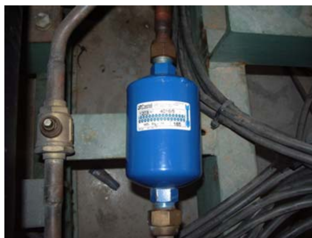
Fig. 4.23 Filtro deshidratador.
