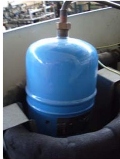
Fig. 4.18 Vaso de expansión del CDC.
