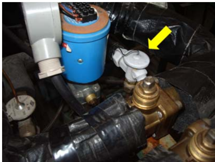
Fig. 4.25 Válvula de expansión termostática.
