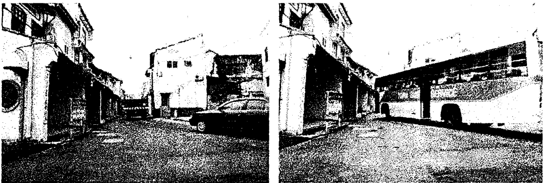
gambar 2.9: Jalan Tun Cheng Lock yang selebar 7 meter amat sempit dan menyukarkan kenderaan-kenderaan besar melaluinya. Ini sering mengakibatkan kesesakan lalu lintas.
