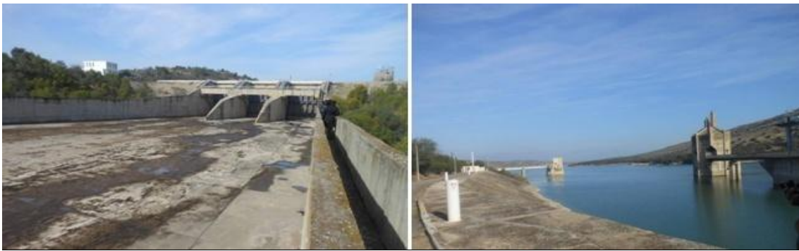
Figure 3.5 : Vue du barrage Sidi Salem et de sa centrale hydroélectrique
