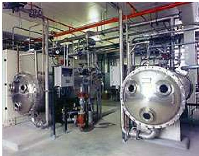
Figure I-7: Photographie représentant deux générateurs d'ozone utilisés pour le traitement des eaux.
