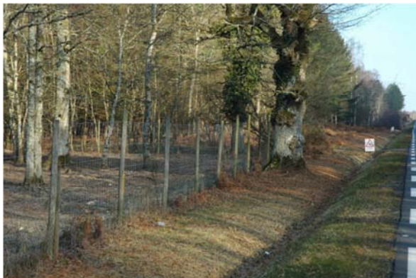
Figure 26 : Grillage double (noter que le bas est doublé avec du grillage plus fin). Noter également le contraste entre la végétation du bas-côté de la route et le sol nu derrière le grillage, ce qui semble attribuable au sanglier
