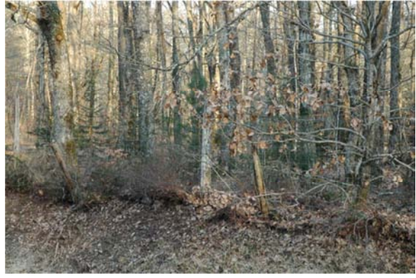
Figure 23 : Grillage double (noter les piquets pourrissants au premier plan, et les piquets neufs en arrière)
