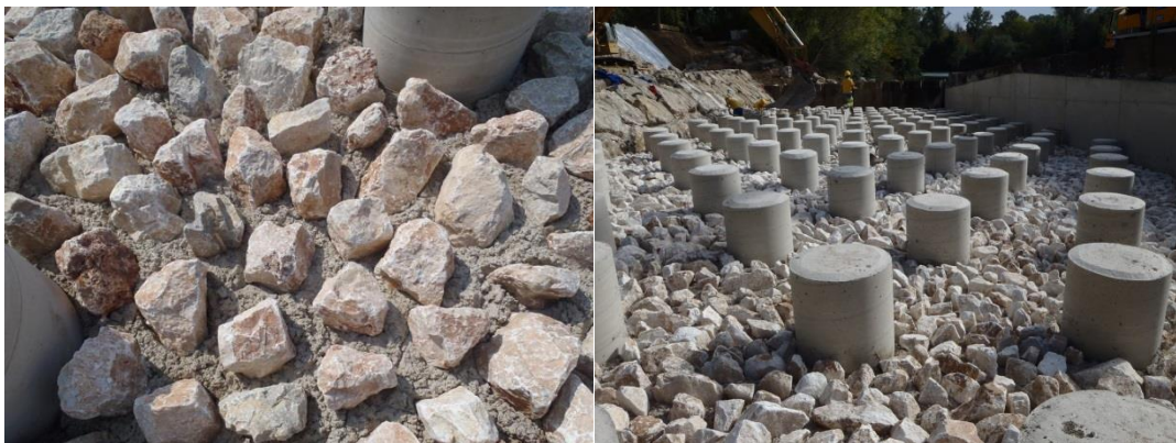
Figure V.18 : Photographie des fonds rugueux pour les passes de Tabarka (gauche) et de Malhaute (droite).
