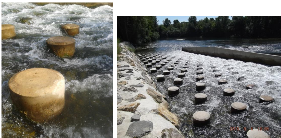
Figure II.12 : Photographies des passes de Tabarka (gauche) et Malhaute (droite).
