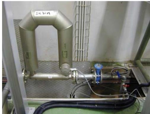
*Figure 4-5 : Débitmètre à effet Coriolis*
