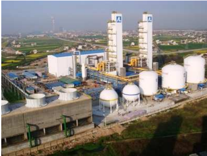
FIGURE 1.2: Photographie d'une unité de séparation de l'air. On reconnaît en bas à gauche les compresseurs, en bas à gauche les cuves de stockage des gaz liquéfiés, au milieu les colonnes de distillation ainsi que le système de purification.
