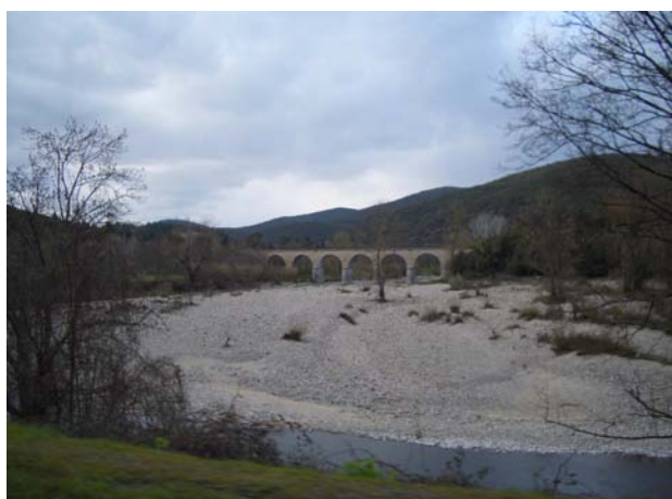
Fig. 4.12 : A l'aval le lit mineur s'élargie à l'intérieur d'une plaine alluviale
