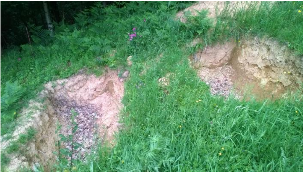
Slika 29: Trenutno stanje, izkopani jami za namen izgradnje rastlinskih gred (Foto: Jasmina Klančnik, 2016)
