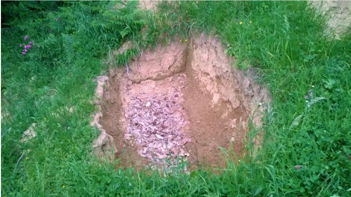
Slika 25: Trenutno stanje, izkopane jame za namen izgradnje rastlinske grede (Foto: Jasmina Klančnik, 2016)
