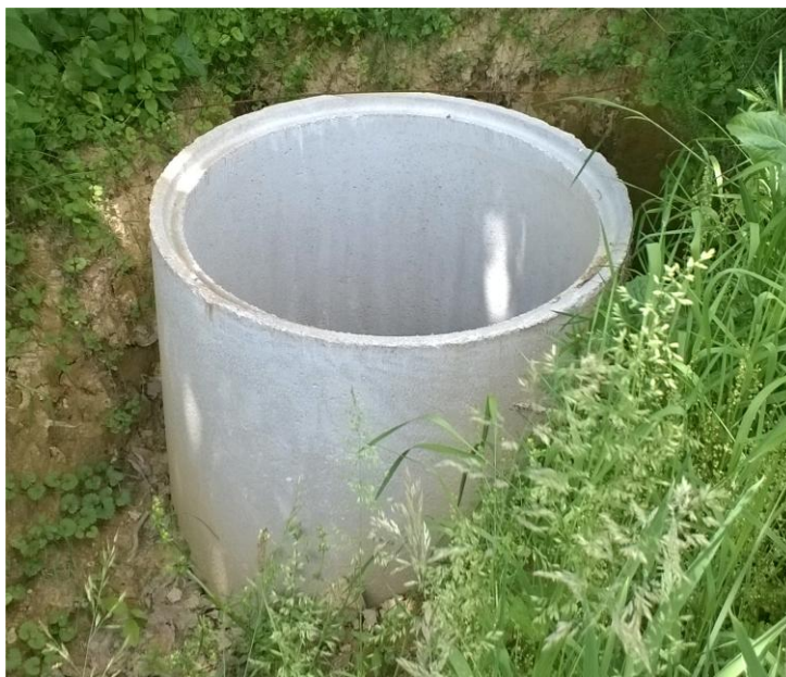
Slika 19: Betonska cev za namen prvega usedalnika (Foto: Jasmina Klančnik, 2016)
