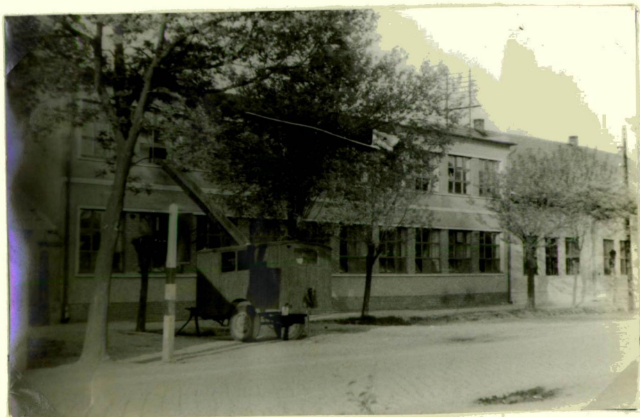
Békési Nyomda főépülete.
