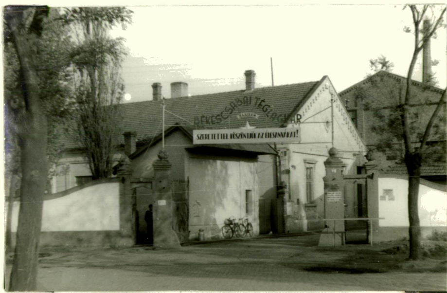
Békéscsabai Téglagyár főbejárata.
