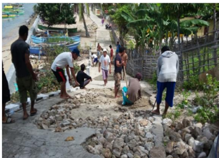
Gambar 7. Kegiatan perbaikan jalan menuju kawasan wisata pantai
