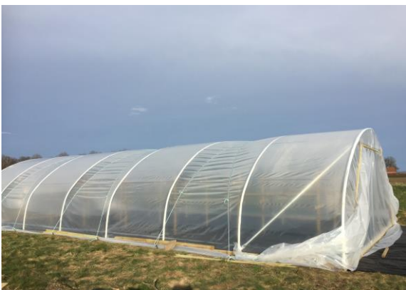
Figur 4. Montering av tunneln färdig.
