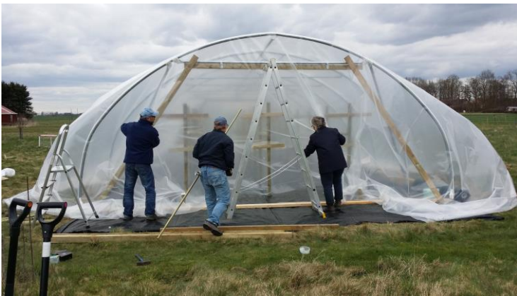
Figur 3. Montering av plasten på tunneln.
