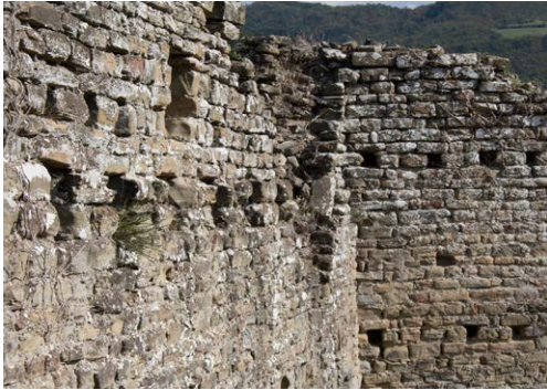
Rastrematura del muro per le buche di solaio
