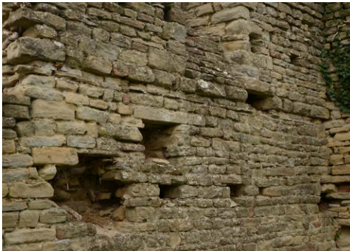
La linea lungo il quale alloggiava il solaio
