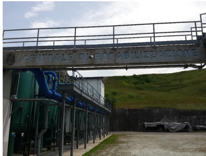
Figura 2.18: Fotografia della centrale di potabilizzazione di Galavotto
