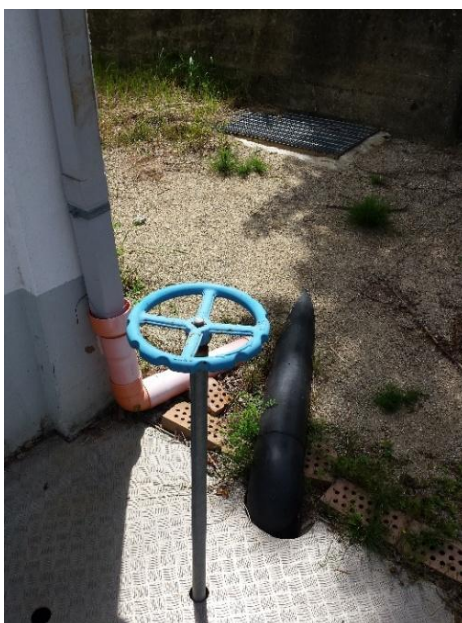
Figura 3.1: Fotografia della valvola a saracinesca per la mandata a scarico dell'acqua proveniente da Canepa
