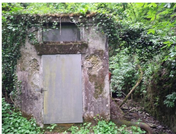
Figura 2.13: Fotografia del “gabbiotto” che costituisce l’opera di captazione
