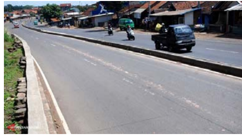
Kondisi Jalan yang Baik
