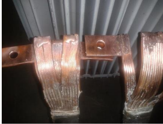
Figura 50. Adecuación de las barras estáticas para las pruebas de ciclado térmico.
