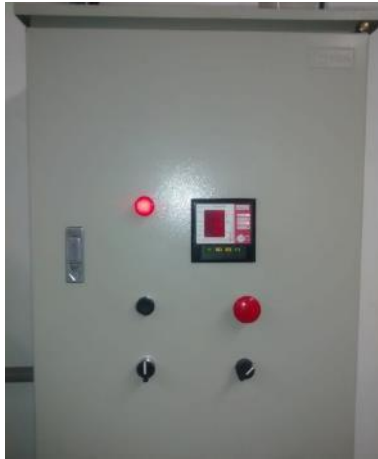
Figura 56. Sistemas de control del Laboratorio de Ensayo de Bobinas: a) Tablero principal de accionamiento y mando, b) Control de potencia independiente para cada barra sometida a esfuerzo térmico.
