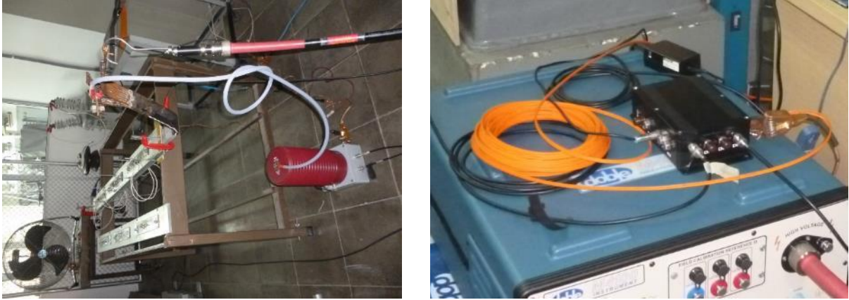
Figura 62. Equipo de medición de descargas parciales TechImp PDCheck MKIV.
