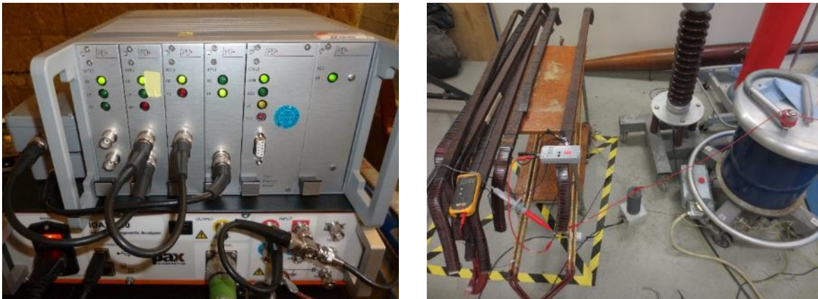
Figura 61. Equipo de medición de descargas parciales PowerDiagnostix ICMSystem.
