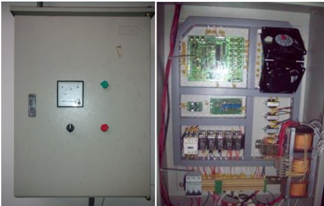
Figura 49. Implementación del sistema de control del grupo motor-generador.
