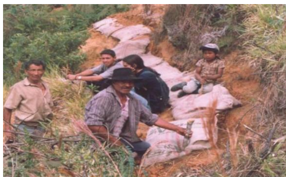
Figura 9. Obras biomecánicas para control de erosión, predio La María, Vereda las Guacas, familia Ortega.
