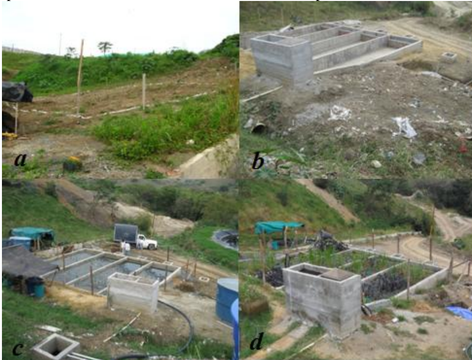
Figura 5. Proceso de construcción del sistema piloto. a. Demarcación de la sección en terreno, para la construcción del sistema piloto completo. b. Construcción inicial del sistema piloto. c. Fase 2 de construcción. d. Fase final del sistema piloto.
