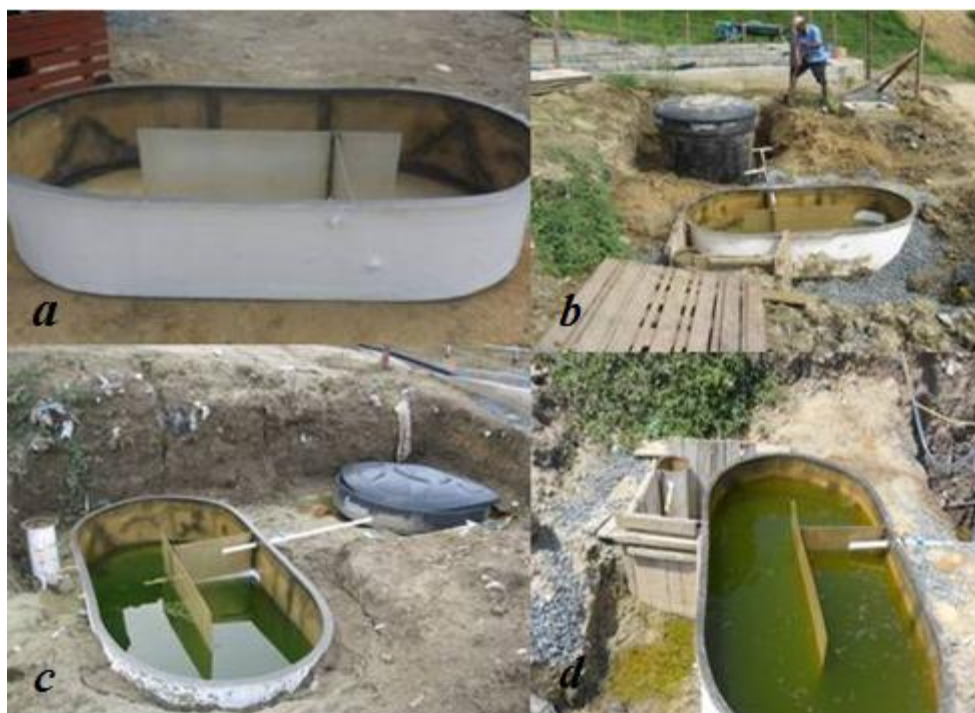
Figura 6. Proceso de instalación de la Laguna algal de alta tasa. a. Laguna piloto antes de la instalación definitiva. b. Instalación del sistema algal de alta tasa. c. Arranque del sistema. d. Puesta en funcionamiento del sistema algal de alta tasa.
