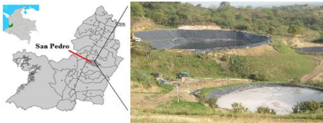
Figura 2. Ubicación del municipio de San Pedro -Vista panorámica del Relleno
