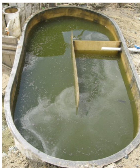
Figura 7. Montaje final de la Laguna algal de alta tasa.
