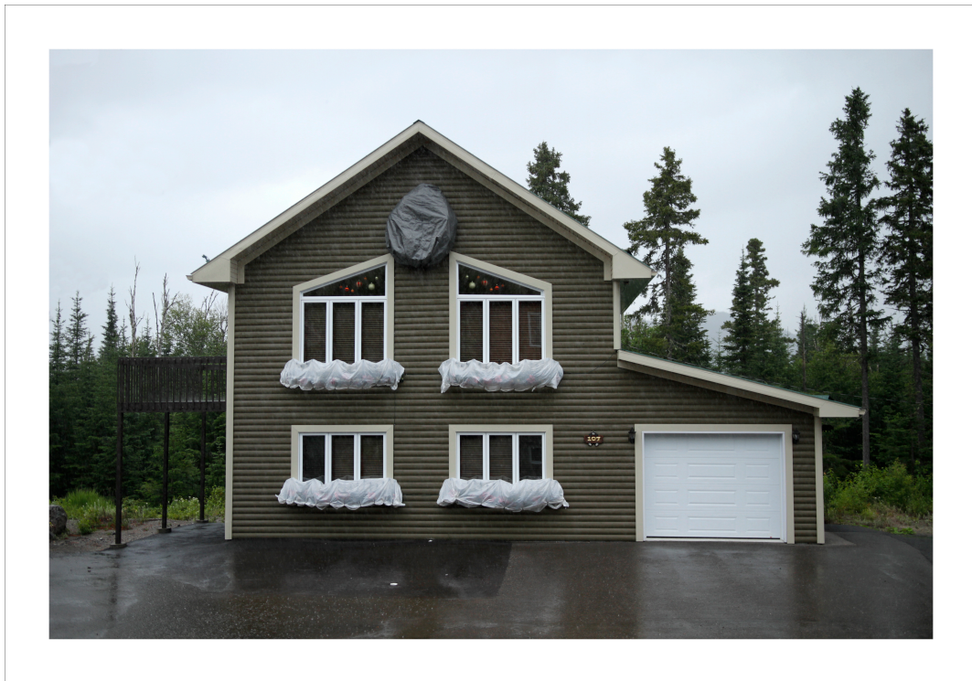
Figure 24 Décorations emballées pour l'été sur un des chalets de la série Saison morte
