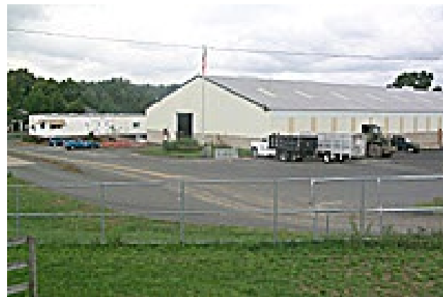
UMA WASTE MANAGEMENT FACILITY
