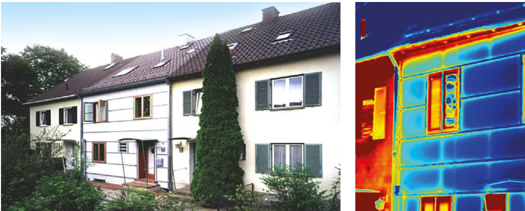
Abbildung 1 Mit Vakuumsolationspaneelen energetisch saniertes Reihenmittelhaus
