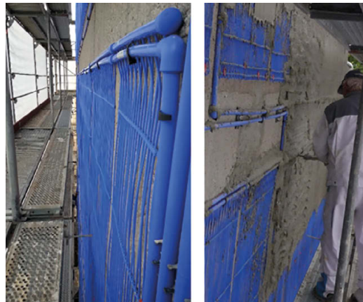
Abbildung 4 Außenliegende Wandheizung: Links: Aufbau der Flächentemperierung Rechts: Verputzung der Heizmatten während der Sanierung von außen
