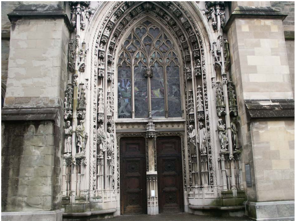
Fig. 3 Le portail principal de la cathédrale montrant sur le pilier gauche des grès altérés (photo : E. Reynard).
