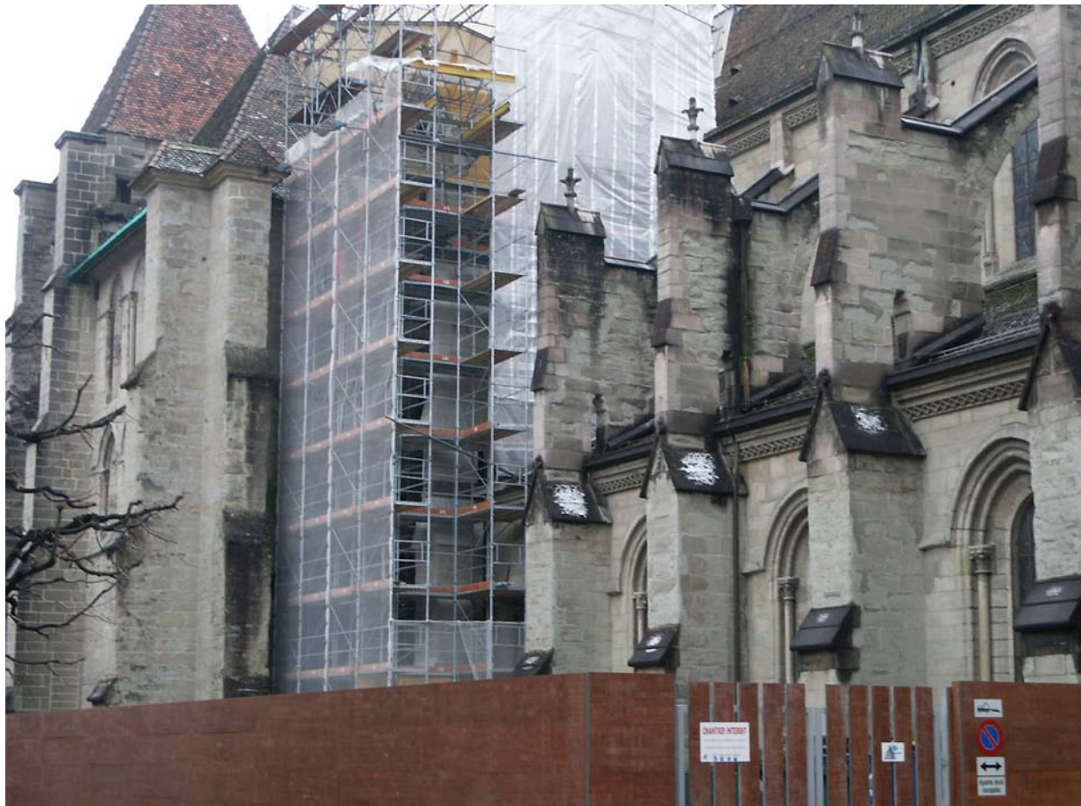
Fig. 4 La cathédrale de Lausanne en chantier de restauration (photo : E. Reynard).
