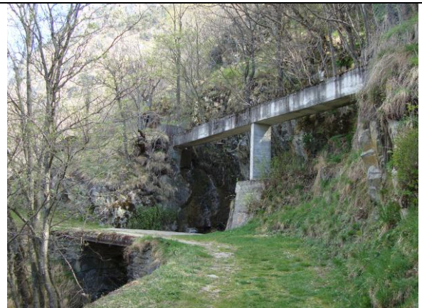
Alter Betonschacht am Steigrächa
