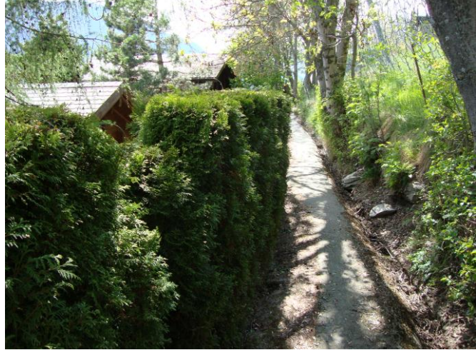
Verrohrter Abschnitt der Grossa oberhalb der Ferienhauszone
