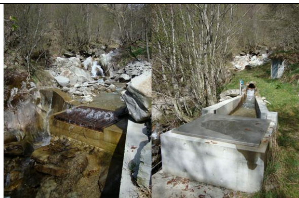
Tirolderwehr-Fassung mit Entsander von Grossa/Understa heute (seit 1971, erneuert 2006-8)
