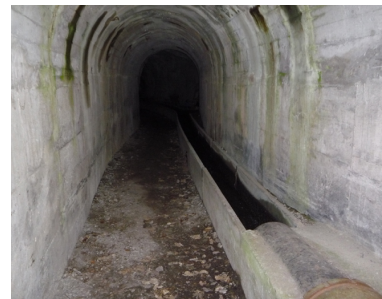
Der 1972 erbaute Stollen
