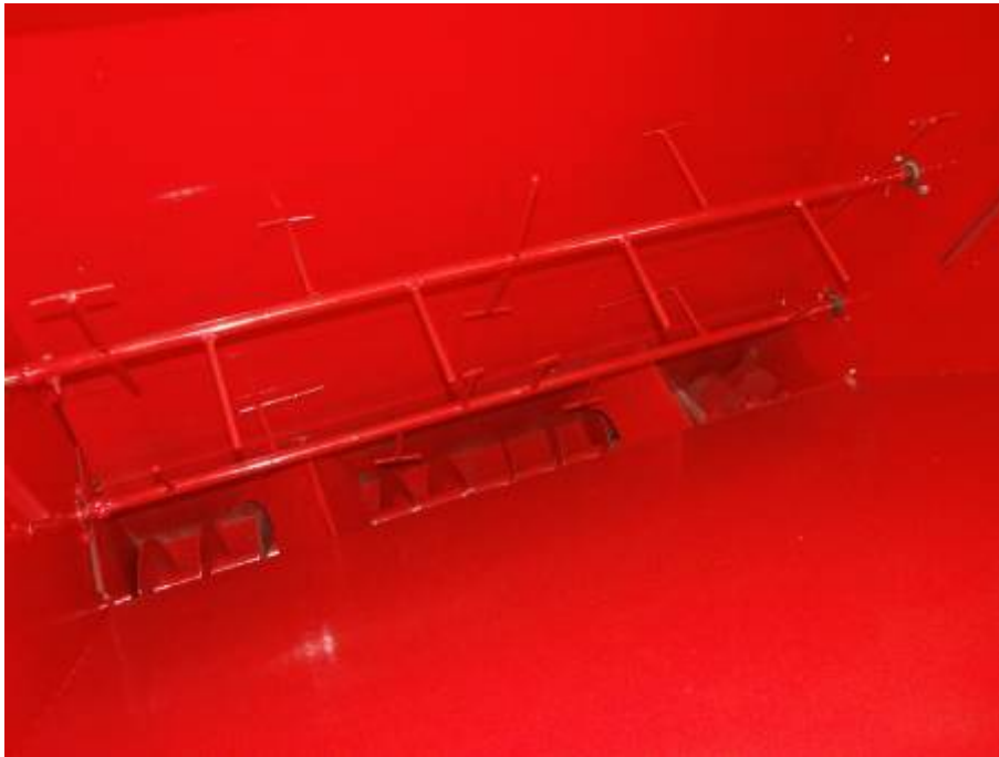
Abbildung 98: Rührwellen oberhalb der Austragsschnecke im Kompostbunker
