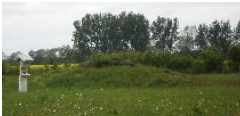
Puits du captage de Lons-le-Saunier
