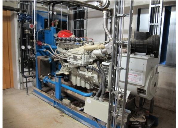
Abbildung 29: BHKW: Biogas für Strom und Wärme. Foto: V. Jaensch, RENAC.
