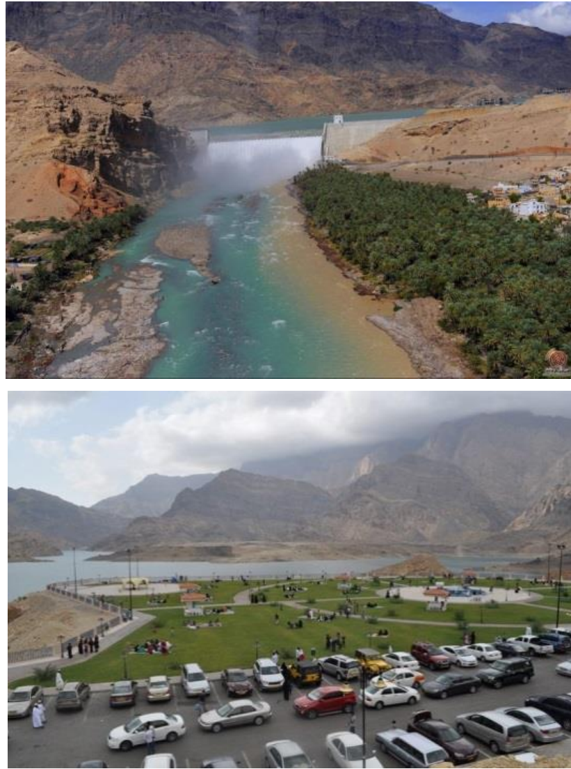
Figure 7.2: Wadi Dhayqa Dam
