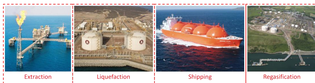
Figure 1.5 - LNG supply chain
