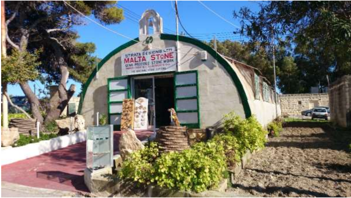
Figure 21 Restored Nissen Huts Ta' Qali
