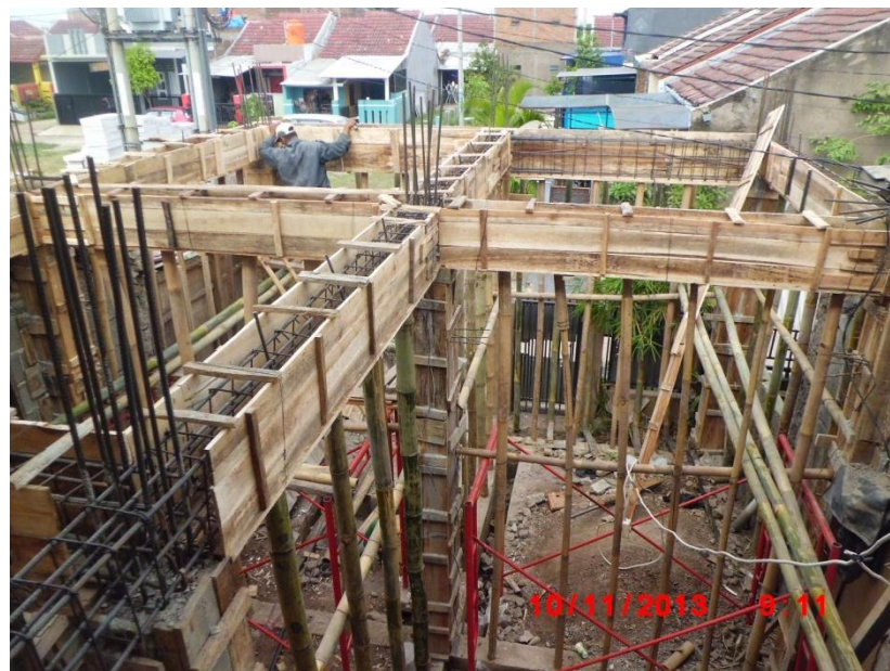
Pengecoran Beton Konvensional Tampak Atas (b)
