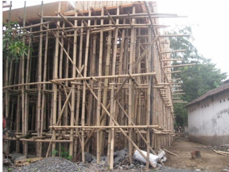
Pengecoran Beton Konvensional Tampak Bawah (a)
