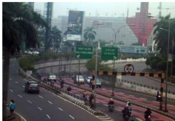
Gambar 6.8 Underpass Pondok Indah Sumber : Dokumen Survei
