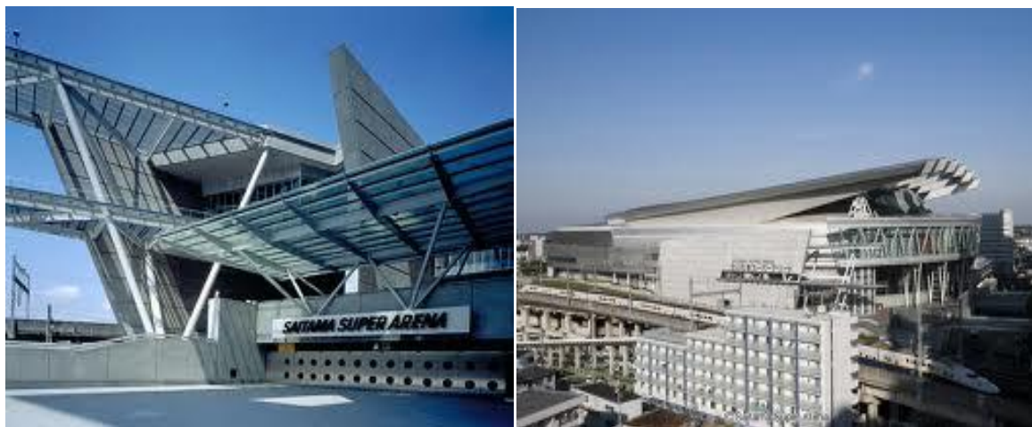
Gambar 5.6. Saitama Arena - 2 Sumber: Dokumentasi Pribadi
