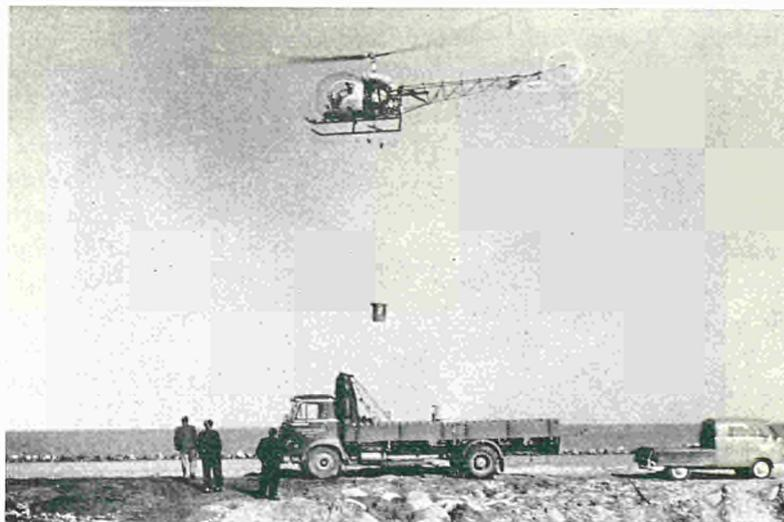
Bild 2 — An der Traverse unter dem Hubschrauber hängt das Sandgefäß
