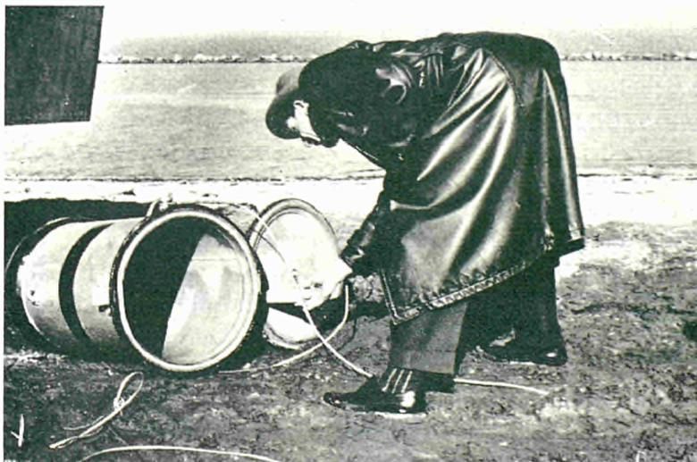
Bild 2 — Sandgefäß wird nach Entleerung auf Restbestände an radioaktiv markiertem Sand kontrolliert (7.3.1962)
