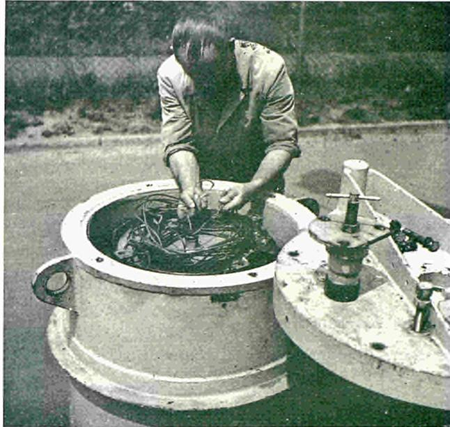
Bild 12 — Einlegen des Kippseiles und der beiden Tragseile auf den Deckel des Sandgefäßes
