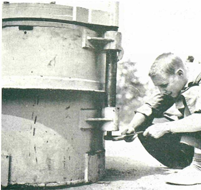
Bild 9 — Achse und Lager zum Ausschwenken des Deckels mit unterer Druckschraube zum Anheben des Deckels
