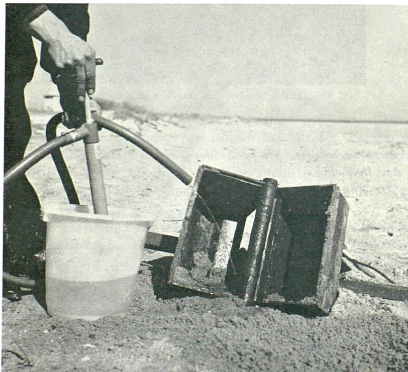
Bild 9 — Reinigen des Greifers mit einer Wasserpumpe
