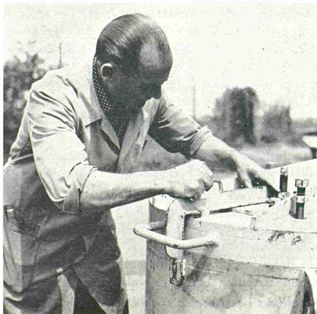
Bild 7 — Verriegelung des Deckels am Abschirmbehälter
