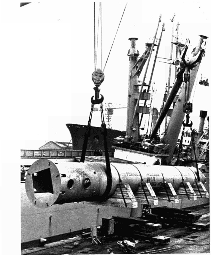
Fig. 11 — Embarquement sur un navire spécial d'un tube de synthèse d'ammoniac de 800 t/j poids 245 t. diamètre 2,586 m, longueur 18,8 m,
