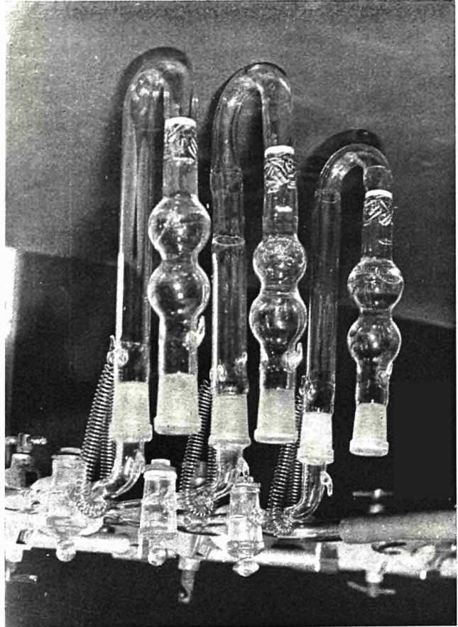
Abb. 1 — Versuchsgerät zur Prüfung der korrodierenden Wirkung von Wässern
