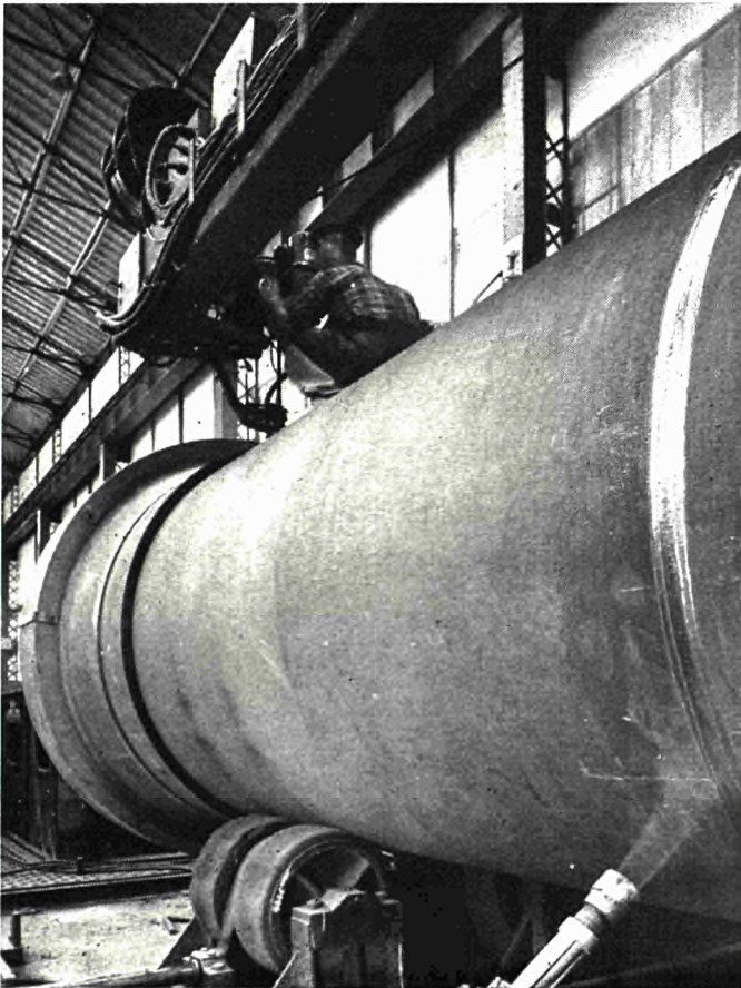
Fig. 8 — Exécution d'un soudure circulaire
