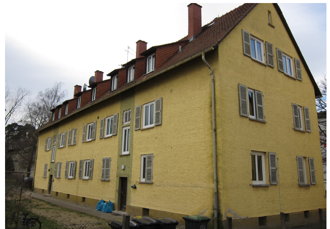
Abbildung 8.9: Ostfassade des unsanierten Fritz-Dächert-Weg 56-58, aufgenommen am 15.01.15.
