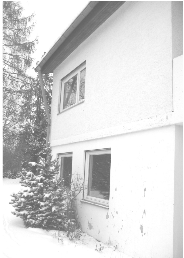
Abbildung 1.5: Westseite des Bestandsgebäudes vor der Sanierung Foto: TUD, FG twe
