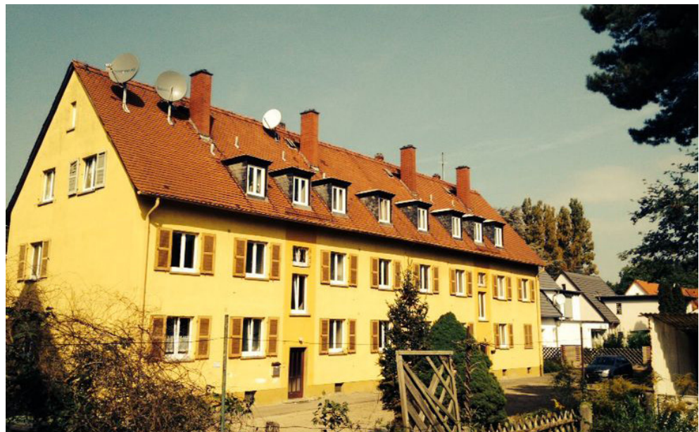
Abbildung 8.1: Fritz-Dächert-Weg, Ostfassade Foto: TUD, FG twe
