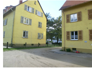
Abbildung 8.5: Bestand Fritz-Dächert-Weg, links: Ostfassade, Durchgang, unten: Grundriss 2.OG, Schnitt, Ansicht Süd Fotos: TUD, FG twe
