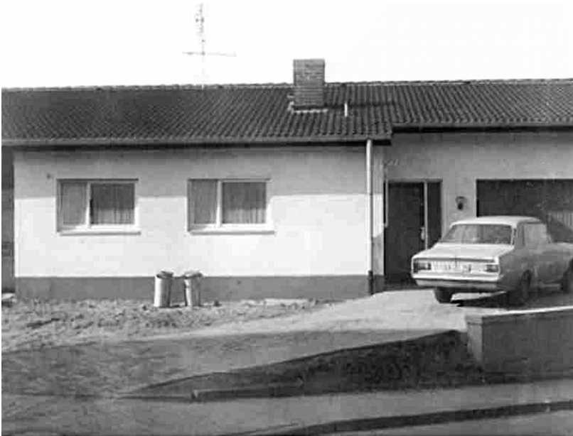
Abbildung 1.2: Ostseite des Bestandsgebäudes nach der Fertigstellung im Jahr 1970 Foto: TUD, FG twe
