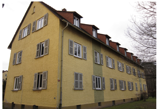
Abbildung 8.11: Westfassade des unsanierten Fritz-Dächert-Weg 56-58, aufgenommen am 15.01.15.
