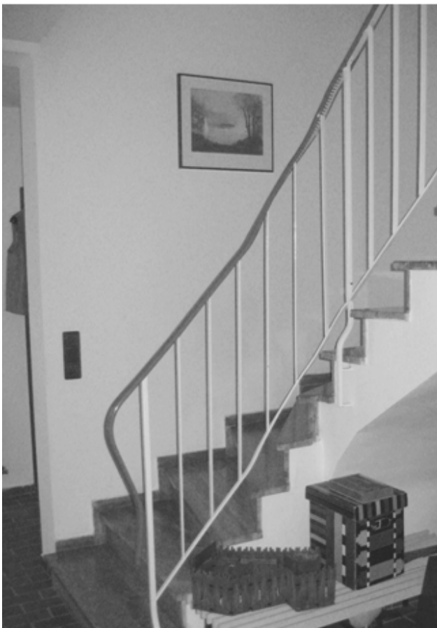
Abbildung 1.4: Treppenhaus des Bestandsgebäudes vor der Sanierung Foto: TUD, FG twe
