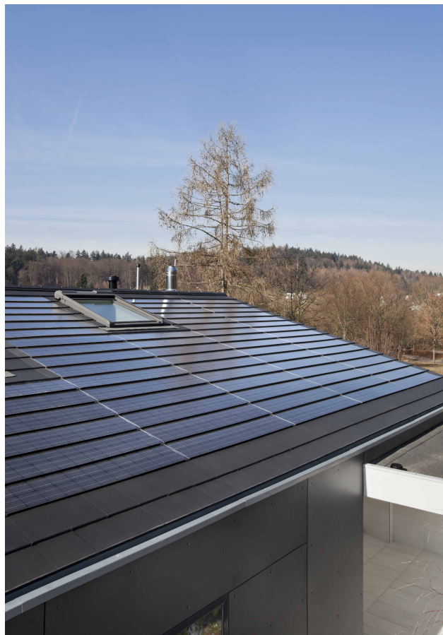
Abbildung 1.9: Dachfläche des sanierten energy+Home im Jahr 2011 Foto: diephotodesigner.de
