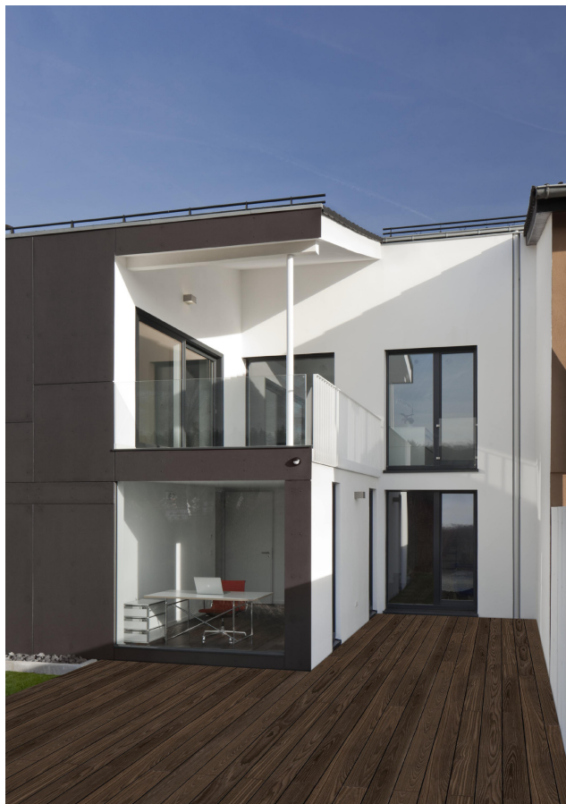
Abbildung 1.8: Terasse des sanierten energy+Home im Jahr 2011 Foto: diephotodesigner.de
