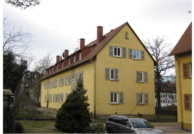
Abbildung 8.10: Nordfassade des unsanierten Fritz-Dächert-Weg 56-58, aufgenommen am 15.01.15.
