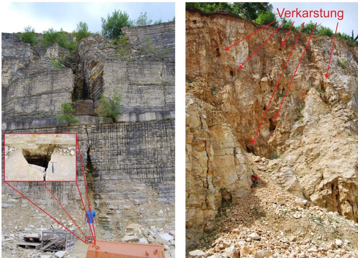
Abb. 5.9: rechts: Verkarstung entlang einer Großklüft im gebankten Kalkstein (Steinbruch Solnhofen), links: großflächige Verkarstung im Massenkalk (Steinbruch Hüllen).
