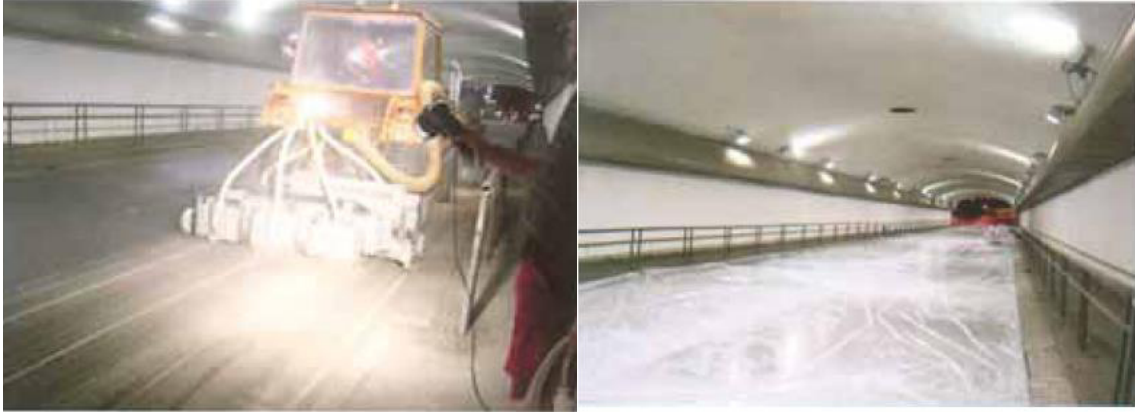
Figura 12. Túnel de Vía Porpora Milán, colocación de un pavimento de concreto con \text{TiO}_2 .
