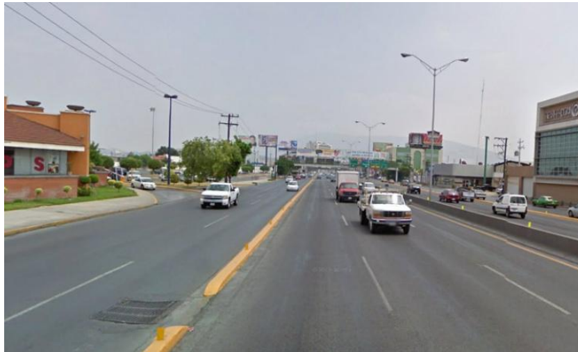
Fig. 3.35 Vista sur-norte del tramo de Av. Ruíz Cortines y Av. Lincoln
