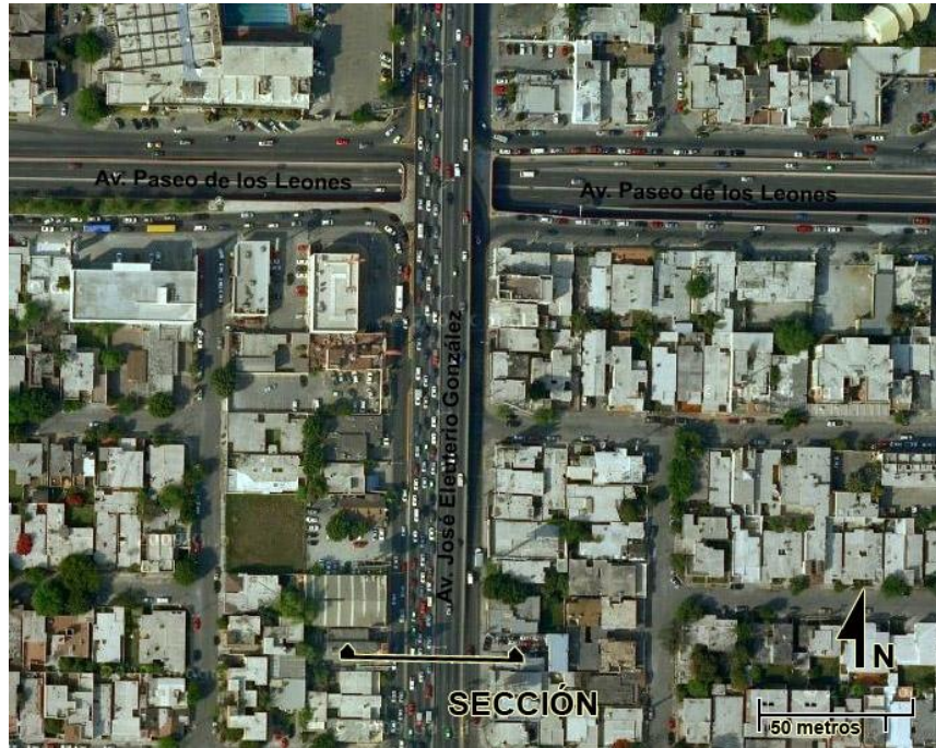
Fig. 3.27 Tramo de Av. Francisco I. Madero a Av. Paseo de los Leones
