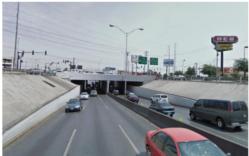
Fig. 3.20 Vista sur-norte del paso deprimido en el cruce de Av. Gonzalitos y Av. Gral. Pablo González Garza. Imagen obtenida de: https://www.google.com.mx/maps
