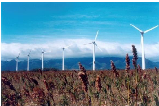
Central Eoloeléctrica La Venta Oaxaca, México
