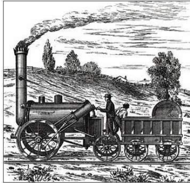
Figura 1. La locomotora inventada por George Stephenson y construida de 1825.
