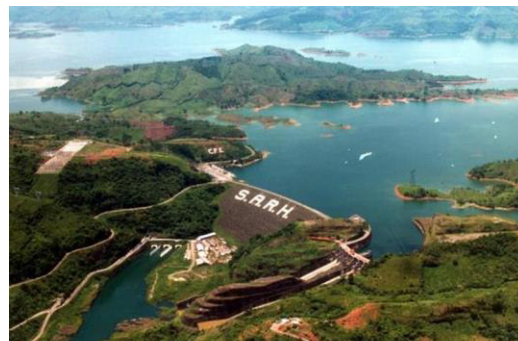
Central Hidroeléctrica Malpaso Chiapas, México
