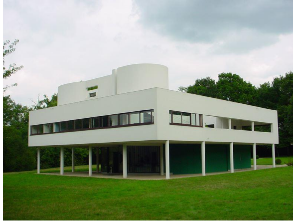
Fig. 1 Exterior de la Villa Savoye (1929)
