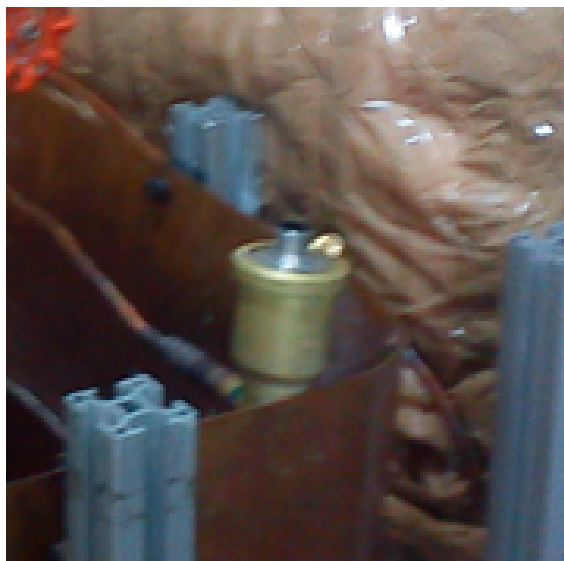
Figura 4.35: Válvula de expansión electrónica.
