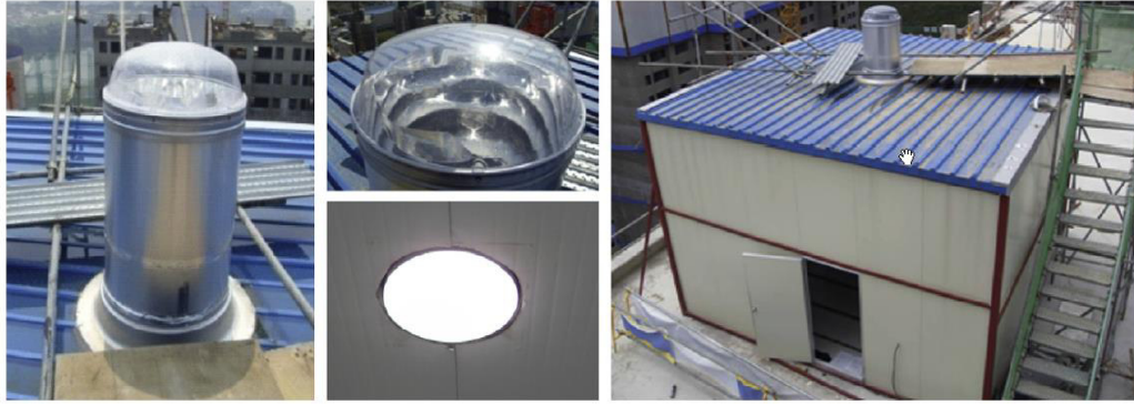
Figura.- 3. Sistema de tubos de luz instalado en el techo 7 .
